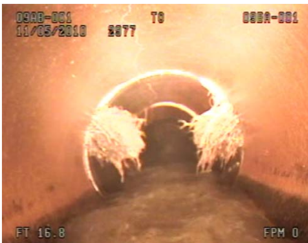
Pipe# 2977 Longitudinal crack
